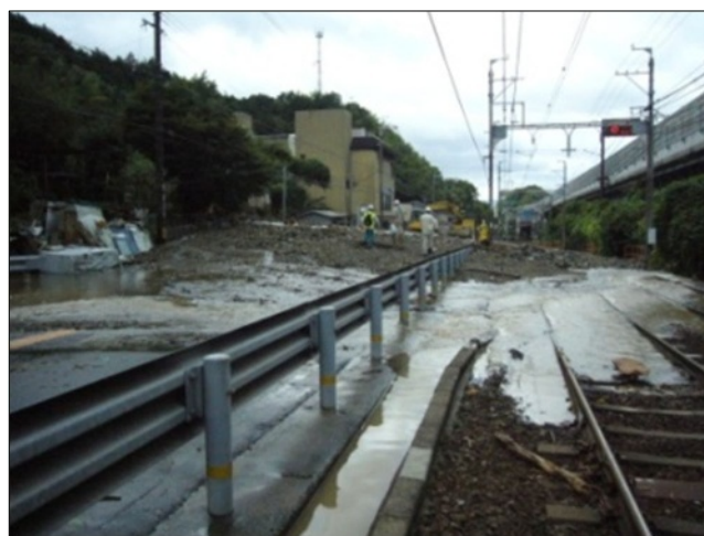
国道1号の被災状況（平成25年台風18号）（大津市追分町付近）
