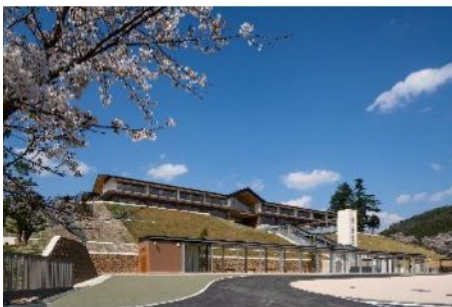
学校統合による、京都京北小中学校（小中一貫教育校）の建設
