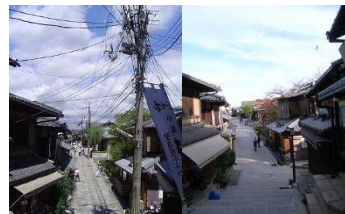
整備前 整備後
