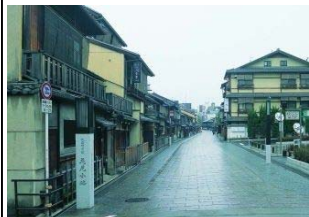
<花見小路における無電柱化と石畳舗装>
