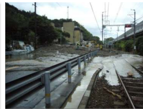
国道1号の被災状況（平成25年台風18号）
