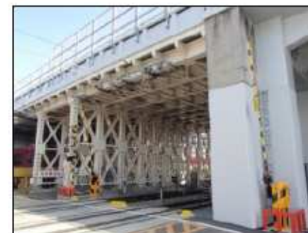
【跨線橋の耐震補強】
