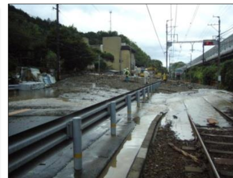
国道1号の被災状況（平成25年台風18号）
