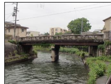
【老朽化した橋りょう】
