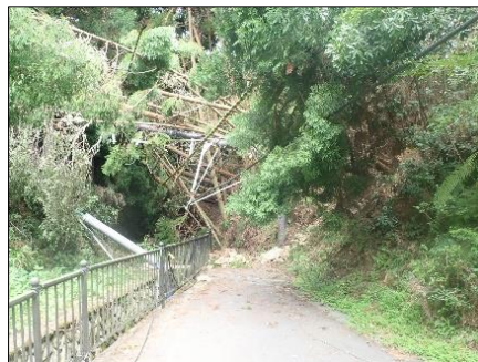
【右京区梅ヶ畑で発生したのり面崩落】 (平成29年8月発災。現在も通行止め)
