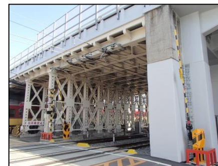
【跨線橋の耐震補強】
