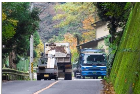
【改良が必要な山間部の道路】
