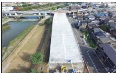
鴨川東岸線整備状況
