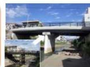
【老朽化修繕状況】
