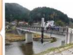
【法定点検状況】
