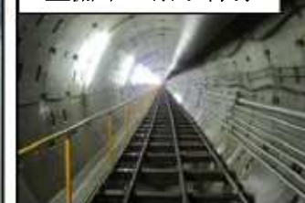
整備中の雨水幹線
