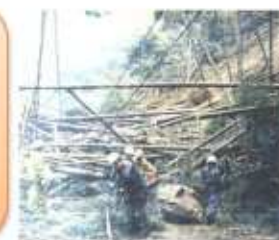
【土砂災害発生状況】
