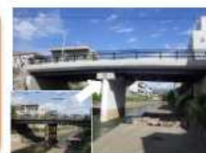
【老朽化修繕状況】
