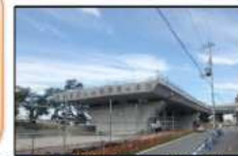
【鴨川東岸線整備状況】
