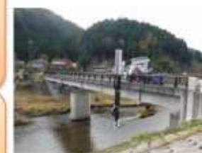
【法定点検状況】
