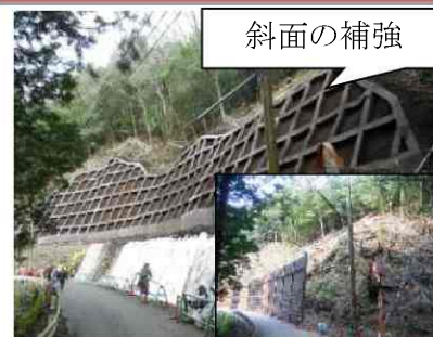
[防災対策を施した道路]
