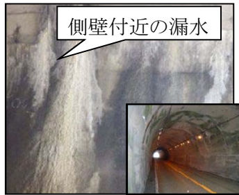
[老朽化が進行する道路ストック (トンネルの壁面)]
