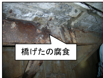
[老朽化が進行する橋りょう]
