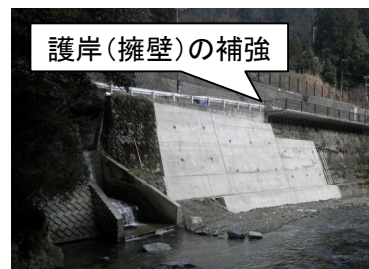
[防災対策を施した道路]
