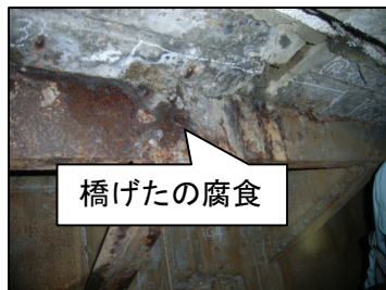
[老朽化が進行する橋りょう]
