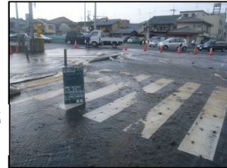
【水道管が破損し吹き出した様子】
