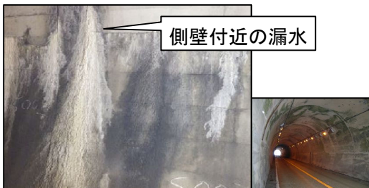
[老朽化が進行する道路ストック] (トンネルの壁面)
