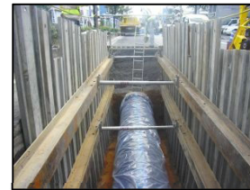
【水道耐震管の布設の様子】
