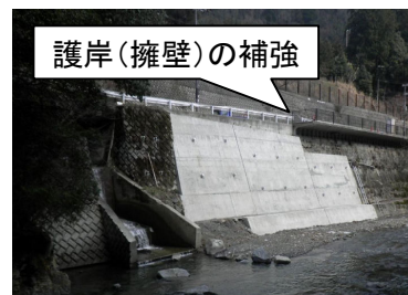
[防災対策を施した道路]
