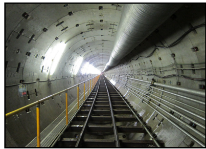
整備中の雨水幹線
