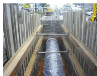
【水道耐震管の布設の様子】
