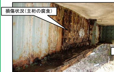
(老朽化が進行する橋りょう)
