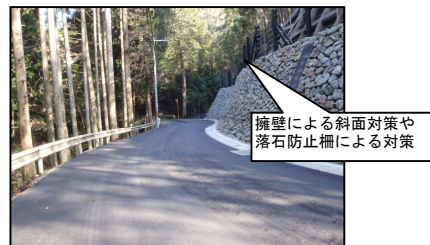
(道路防災 実施例)
