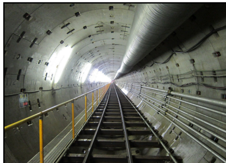
整備中の雨水幹線
