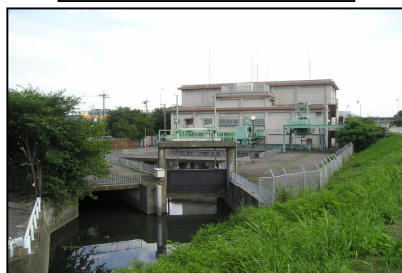
老朽化が進む排水機場
