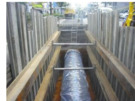
【水道耐震管の布設の様子】
