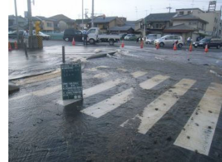
【水道管が破損し吹き出した様子】
