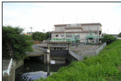
老朽化が進む排水機場
