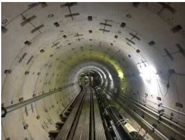
(整備中の雨水幹線)
