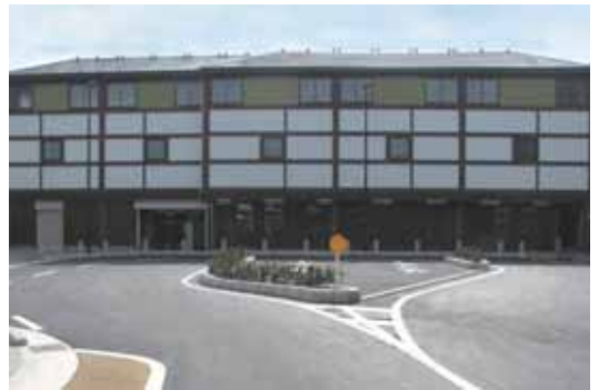
嵯峨嵐山駅自転車駐車場
