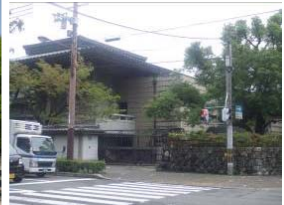
京都市武道センター
