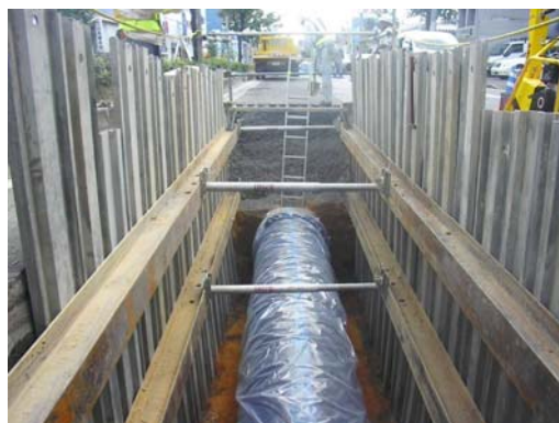
水道管の改築更新
