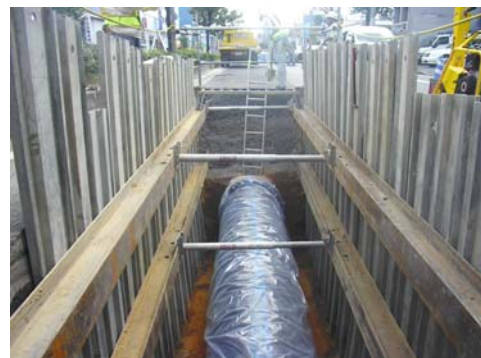
水道管の改築更新
