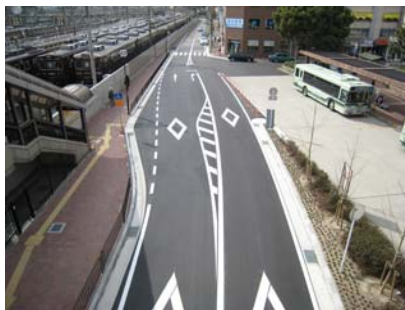
桂駅西口整備状況
