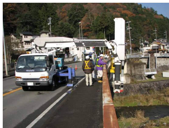
橋りょう点検状況
