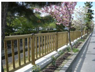
間伐材を活用した転落防止柵 (東堀川通)
