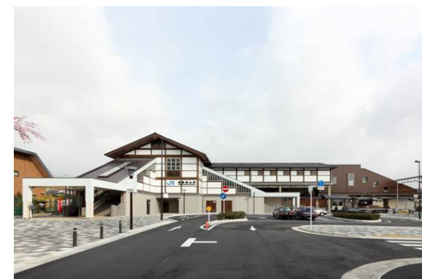
嵯峨嵐山駅自由通路及び橋上化整備状況
