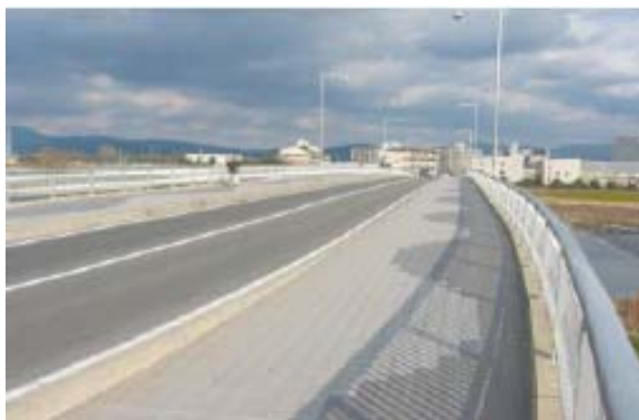
久我橋整備状況
