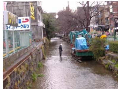
老朽危険橋の撤去（高瀬川）
