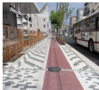
無電柱化事業に伴う 自転車歩行者道の再整備 (北大路通)
