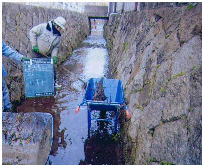
河川浚渫状況
