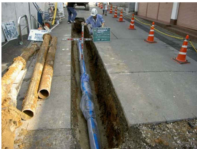
水道管の布設替え
