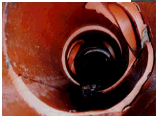
改築更新が必要な老朽下水管路
