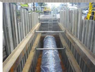
水道管の改築更新
