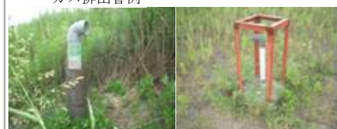
既設ガス抜鉛直管(φ60)
