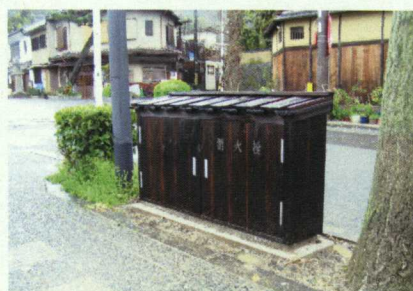
市民用消火栓
