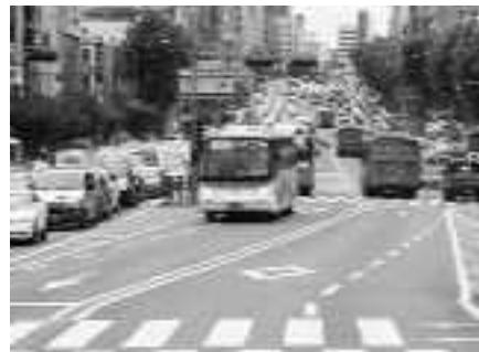
写真5 道路中央に設置されたバス専用レーン
