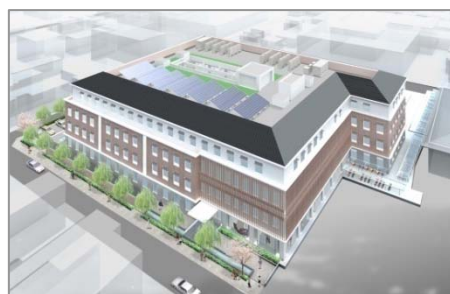
新伏見区総合庁舎の建設等
