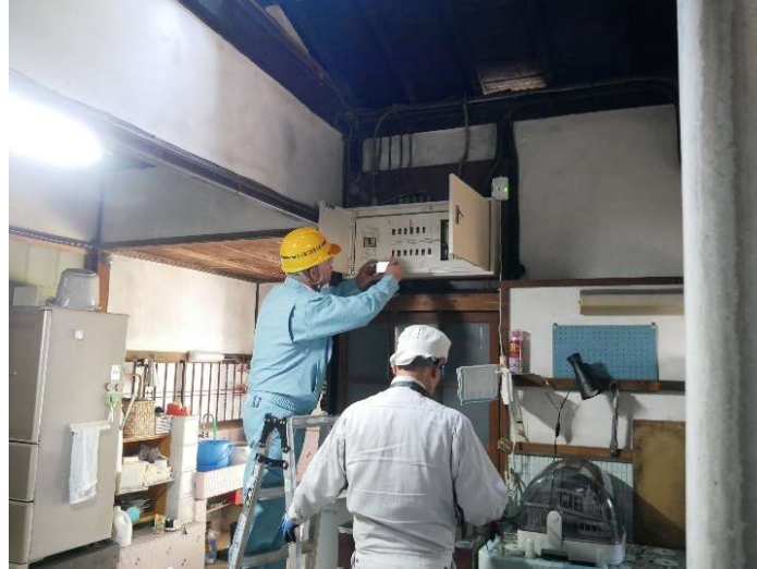
令和 6 年 電気設備安全点検の様子
