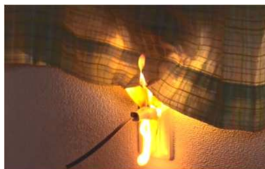
【配線器具（コンセント）からの出火】
