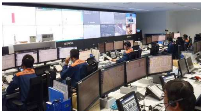
消防指令センター
