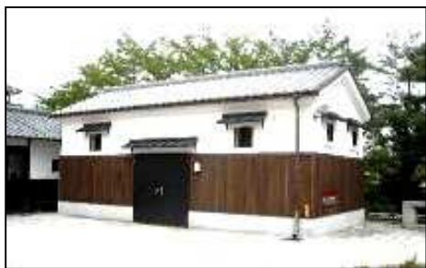
景観に配慮した送水用動力ポンプ庫
