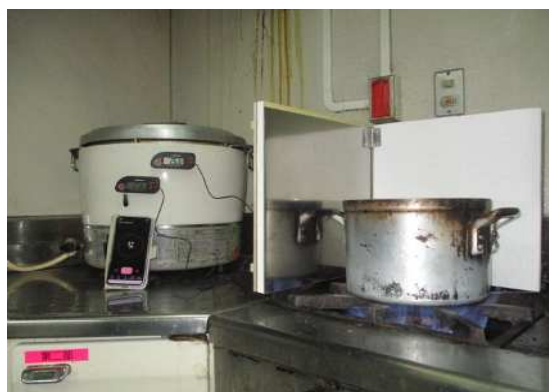
厨房のコンロ横に設置した状況
