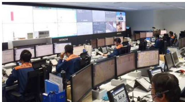
消防指令センター
