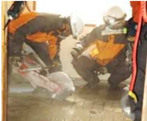
解体予定建物を活用した震災救助
