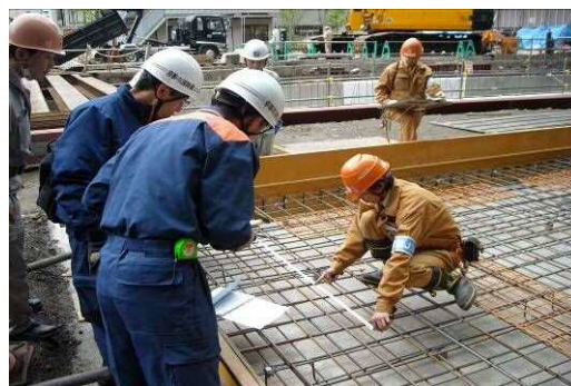
危険物地下タンク貯蔵所の中間検査
