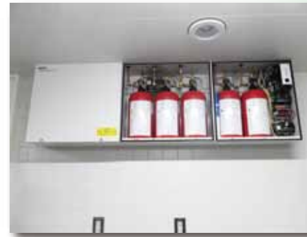
②-3の自動消火装置 (消火剤貯蔵容器)
