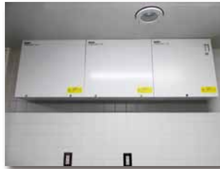
②-3の自動消火装置 (消火剤貯蔵容器)
