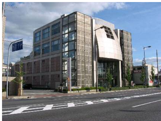
市民防災センター
