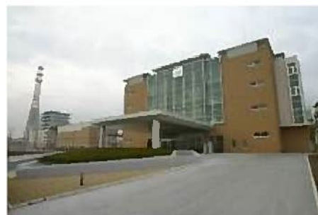
現消防学校 (南区)
