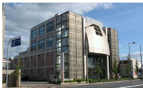
市民防災センター
