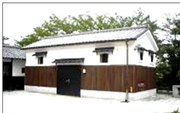
日本瓦、砂壁、桧羽目板張等、景観に配慮した送水用動力ポンプ庫
