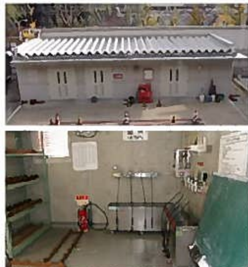
定置式空気製造施設
