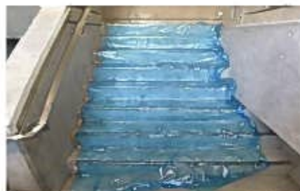
マスカーを使用しての養生
