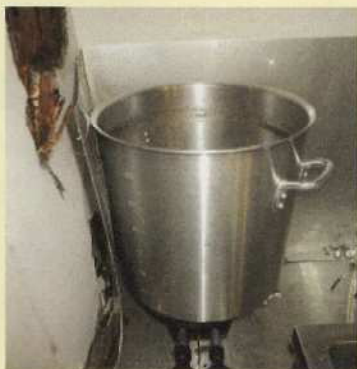
調理器具を壁に近接して使用していた
