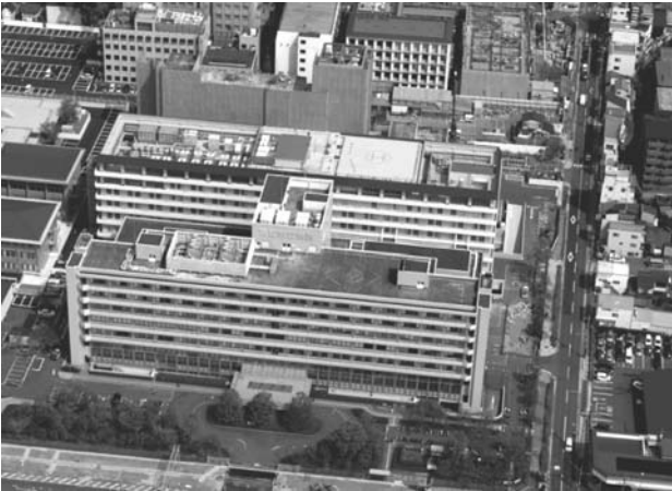
緊急離着陸場（京都市立病院）
