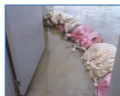
水防工法訓練
