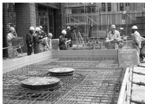
危険物地下タンク貯蔵所中間検査
