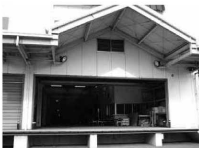
京都市災害物資搬送センター (拠点備蓄倉庫)
