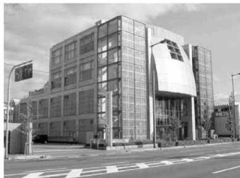
市民防災センター
