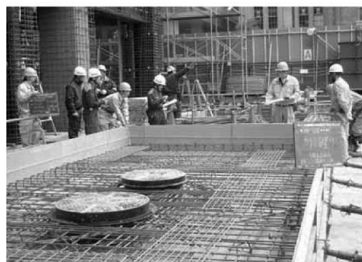
危険物地下タンク貯蔵所中間検査
